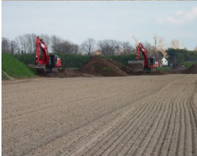
vorsorgender Oberbodenabtrag & -auftrag
